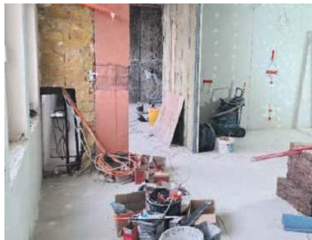
Nowy blok porodowy będzie funkcjonował od lutego. Remont dobiega
