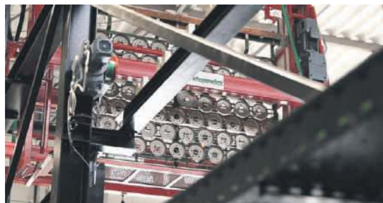
Nowa linia galwaniczna do powłok cynk, cynk-nikiel jest w pełni zautomatyzowana.
