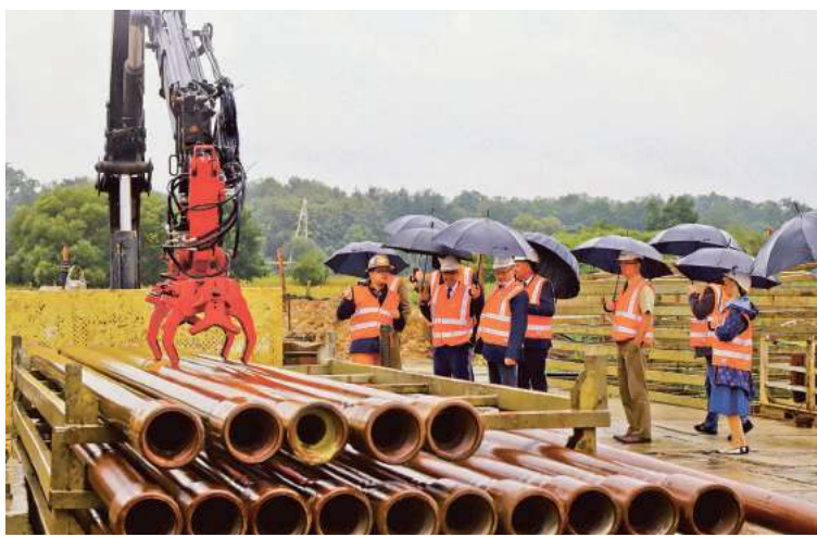
Gaz ma popłynąć nową siecią na przełomie 2020 i 2021 r.
