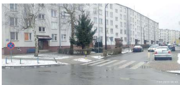
Zgodnie z planem szlaban na wewnętrznej ulicy Nadstawnej ma zostać zamontowany tuż za przejściem dla pieszych
