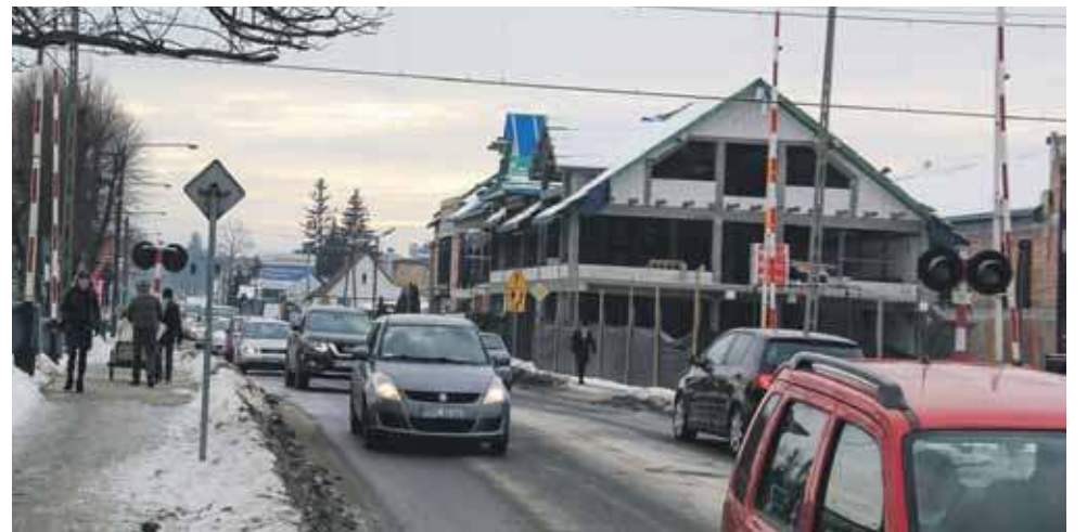
Przejazd kolejowy na ul. Ludźmierskiej - tu wciąż tworzą się korki, nie tylko po każdym przejeździe pociągu. O tym, że jakieś rozwiązanie jest niezbędne - przekonani są wszyscy.
