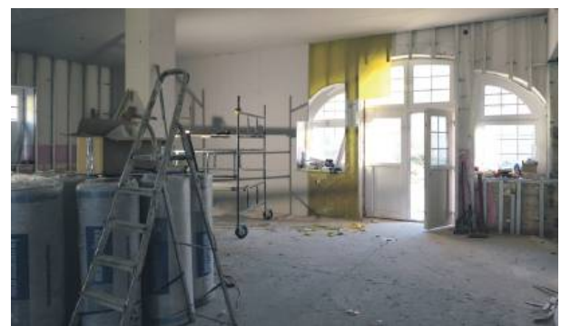
W budynku świetlicy wiejskiej w Jaworowie trwają obecnie prace remontowe
