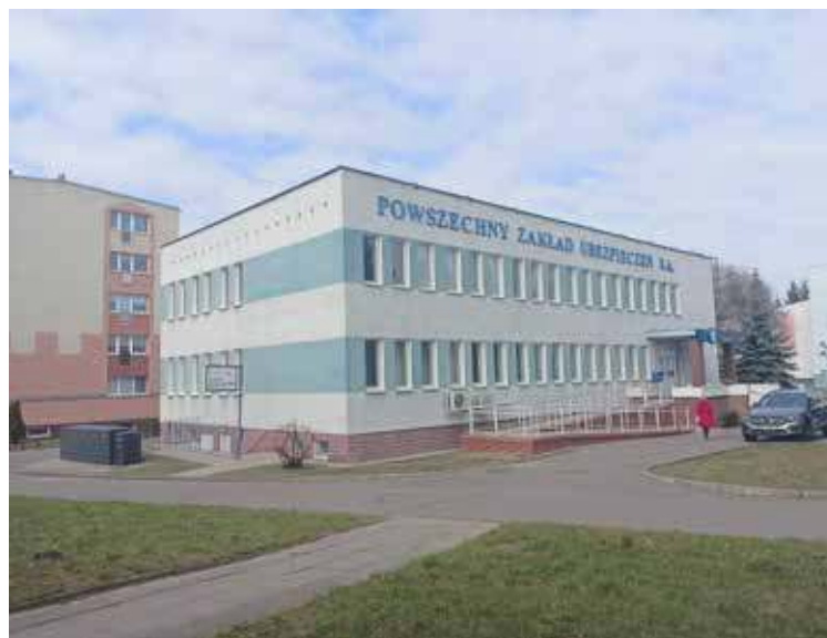
Jeden ze schronów znajduje się w budynku PZU
