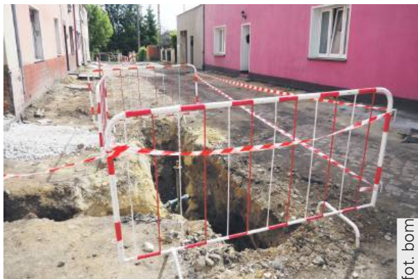
Prace na ulicy Sikorskiego w Wiązowie
