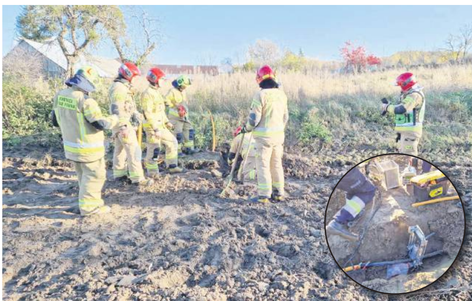
Do awarii doszło na polu w odległości 100 m od zabudowań. Strażacy przy użyciu zaciskarki do rur uszczelnili wyciek.
