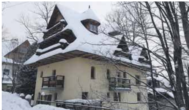
Stojący nad potokiem pustostan będzie wyburzony.
