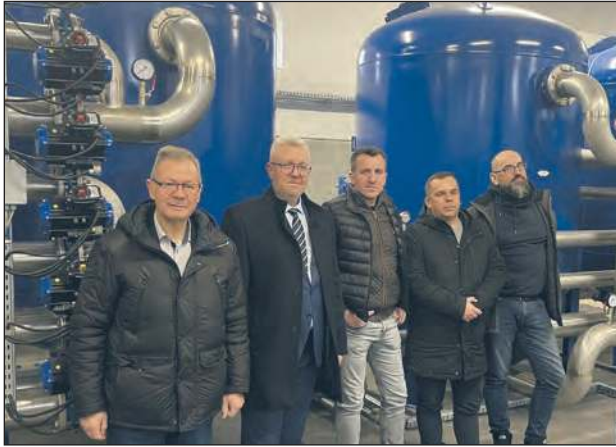
« Zakończyły się prace związane z modernizacją Stacji Uzdatniania Wody w Nowym Goniwilku
