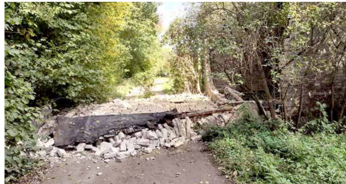
W miejscowości Mariankowo ściana stodoły zawaliła się na drogę. Foto. OSP. Marianowo
