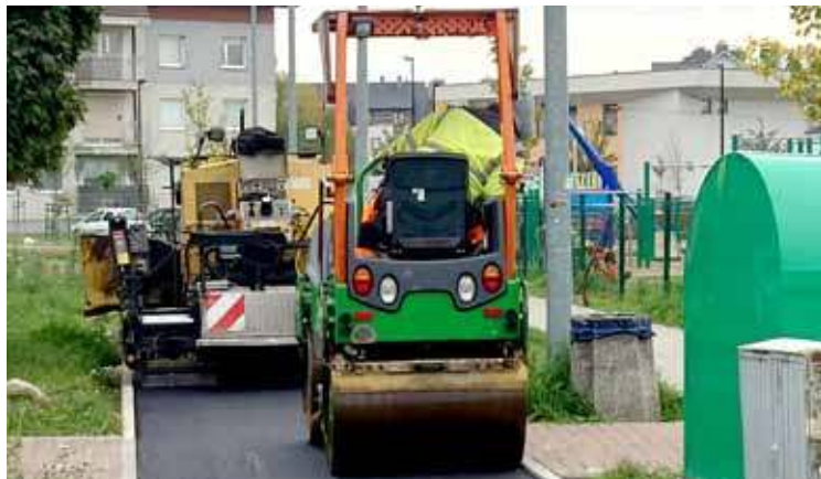
Na nowej trasie dla rowerzystów wzdłuż ul. Armii Krajowej układana jest już pierwsza warstwa bitumiczna
