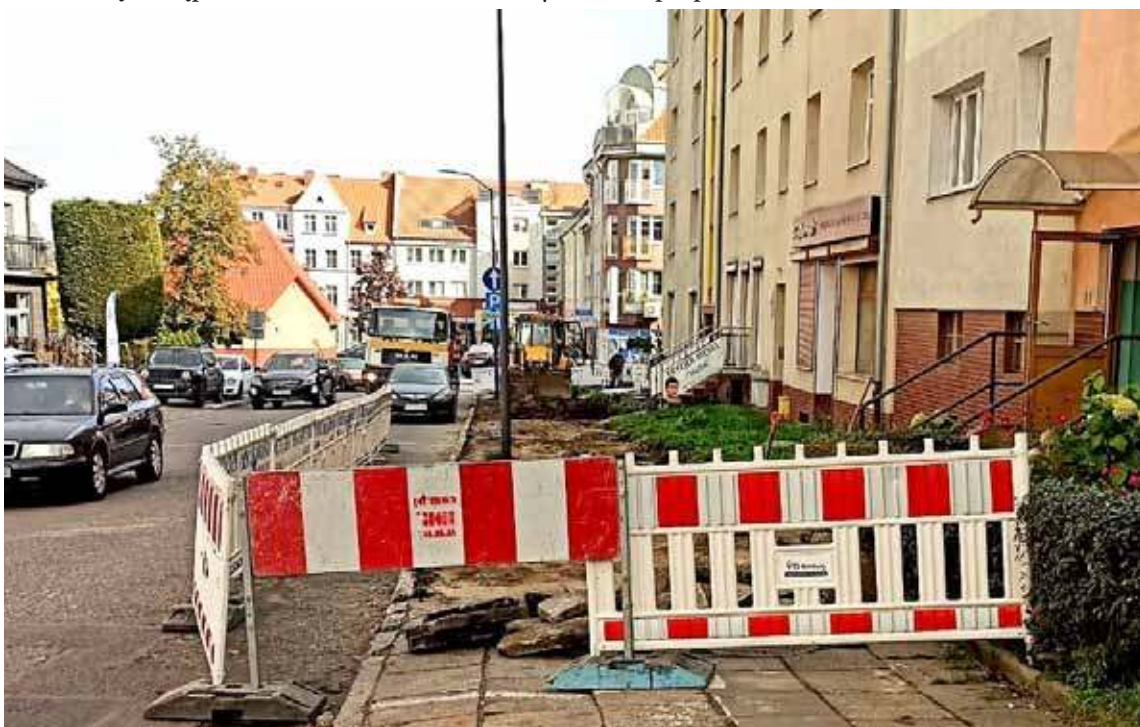
W ramach prac inwestycyjnych część chodnika na ulicy Reja zostanie wyremontowana
