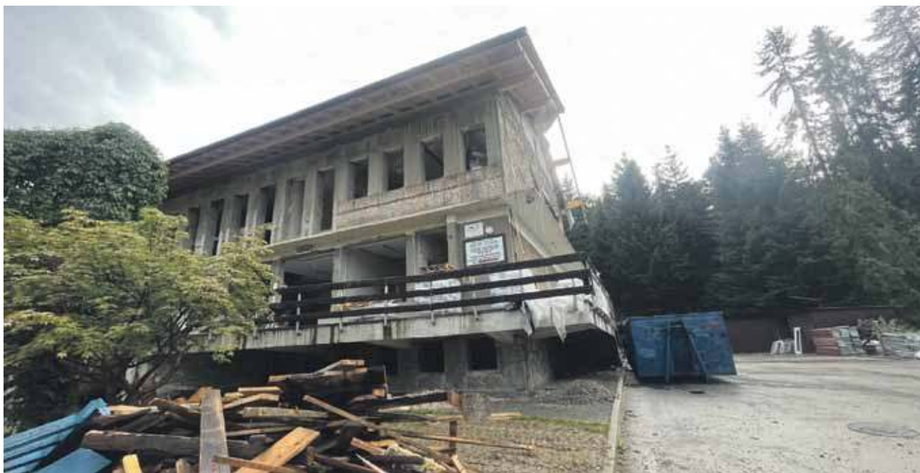
Stacja Centralna w przebudowie.
