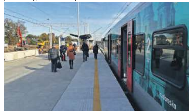
Stacja Zgierz z pierwszym odnowionym peronem, w budowie są kolejne dwa perony i nowe przejście podziemne
