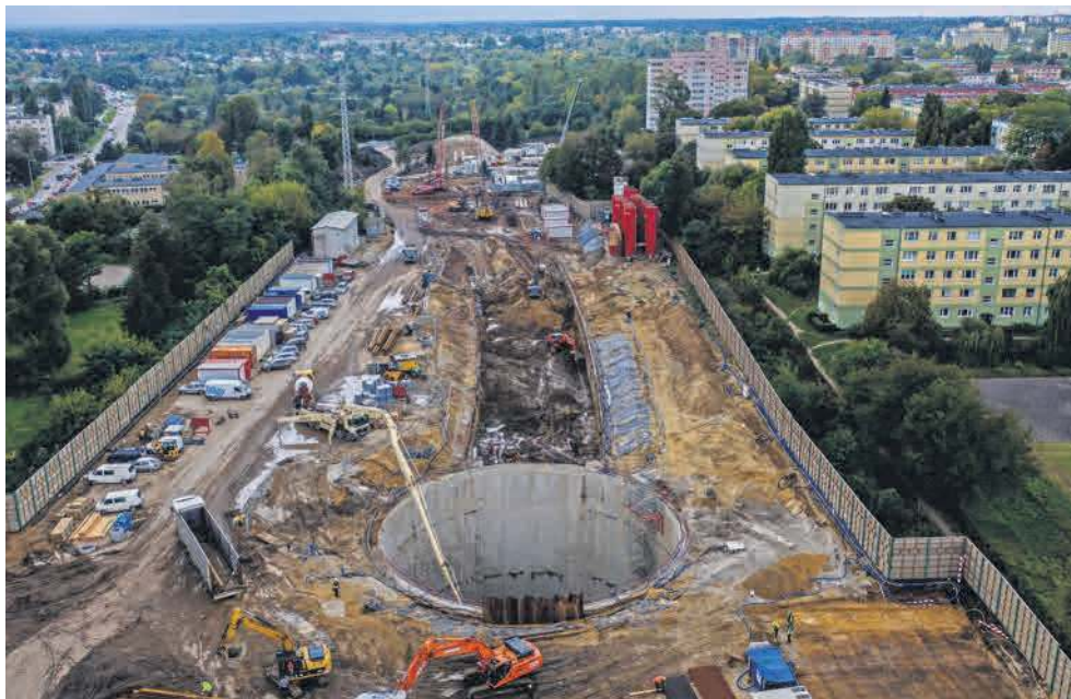
Na budowie tunelu średnicowego w Łodzi widać szyb komory startowej dla dużego TBM, który wydrąży tunel do Łodzi Fabrycznej
