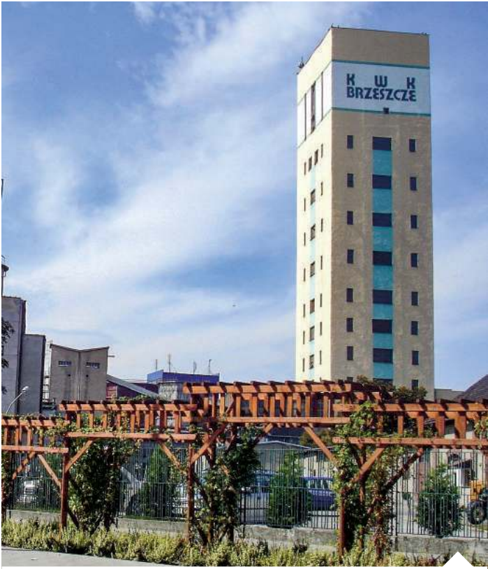
Zakład Górniczy Brzeszcze uruchomił system wytwarzania prądu i ciepła zasilany metanem | fot. Wikipedia/d
