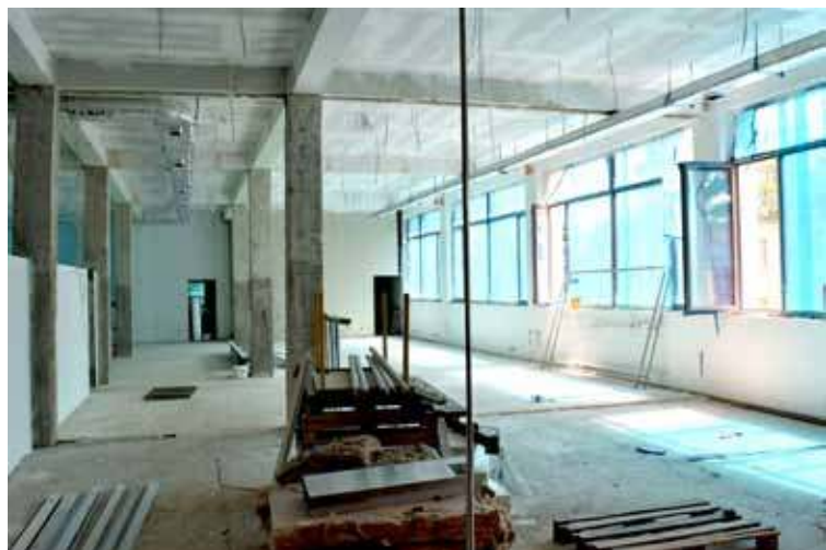
Intensywne prace trwają również wewnątrz budynku
