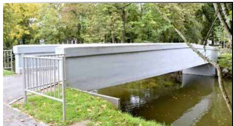
W dniach 6 i 7.07 na moście łączącym Park Piastowski z Parkiem Jagiellońskim przeprowadzane będą prace remontowe. W tych dniach most będzie zamknięty
