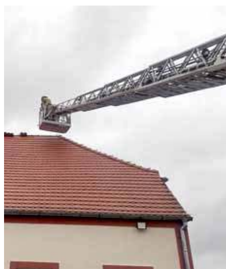
Wichura uszkodziła dach budynku mieszkalnego w miejscowości Wiechowo. Foto. OSP. Marianowo
