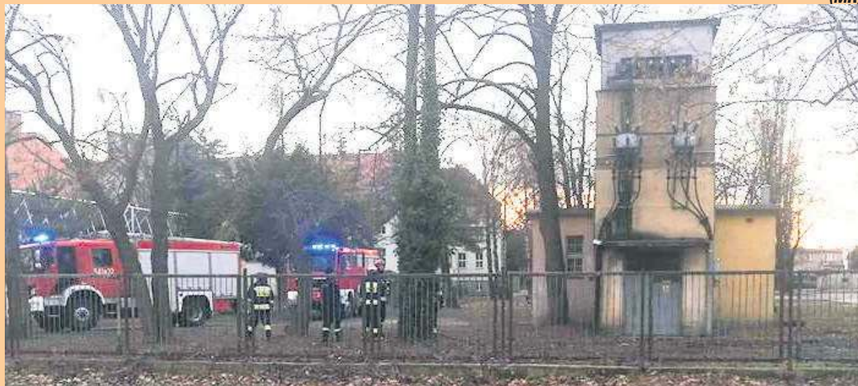
W transformatorze widoczne było iskrzenie (Foto: Strzelin998)
