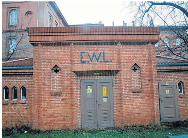
Stacja transformatorowa przy ul. Muzealnej. EWL to skrót: Elektricitats Werke Liegnitz
