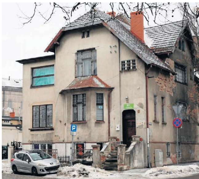
Budynek przy ul. Partyzantów 31. Obiekt pochodzi z początku XX wieku
