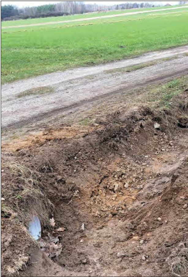
➤ Rów i przepust zostały wykonane
