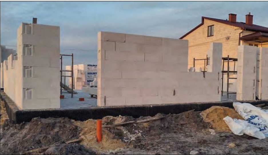
Obiekt powstaje na istniejących fundamentach
