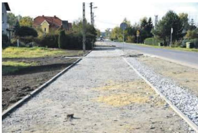
Trwają prace na ulicy Długiej w Szewcach przy budowie ciągu pieszo-rowerowego
