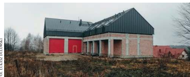
Dom wiejski w Pogorzycach ma być oddany do użytku na początku 2021 r.
