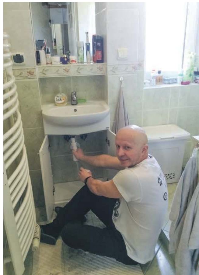
Krzysztof Łukasik przymusowy czas w domu na kwarantannie wykorzystuje m.in. na drobne prace remontowe
