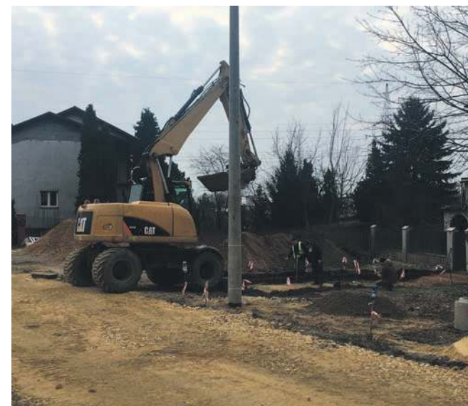
Prace drogowe na ulicy Szewskiej
