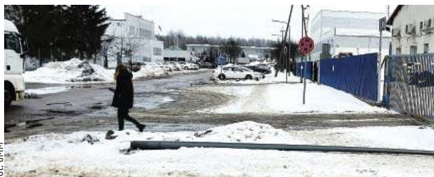
Uszkodzony słup przy ul. Instalatorów w Mławie
