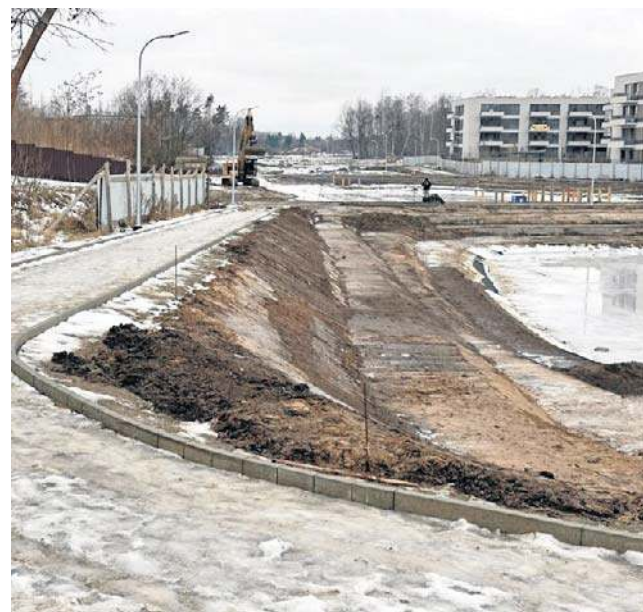
Na radomskim Wacynie budowany jest park z ośmioma stawami. Tak obecnie wygląda stan robót.
