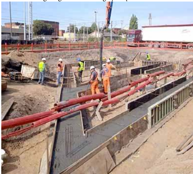
Prace przy budowie parkingu Park&Ride idą pełną parą
