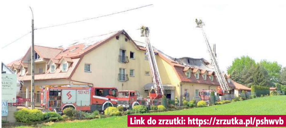
Pożar wybuchł wczesnym rankiem. Przez całą sobotę walczyło z nim ok. 160 strażaków. Czego nie zniszczył ogień, zalała woda użyta podczas akcji gaśniczej
