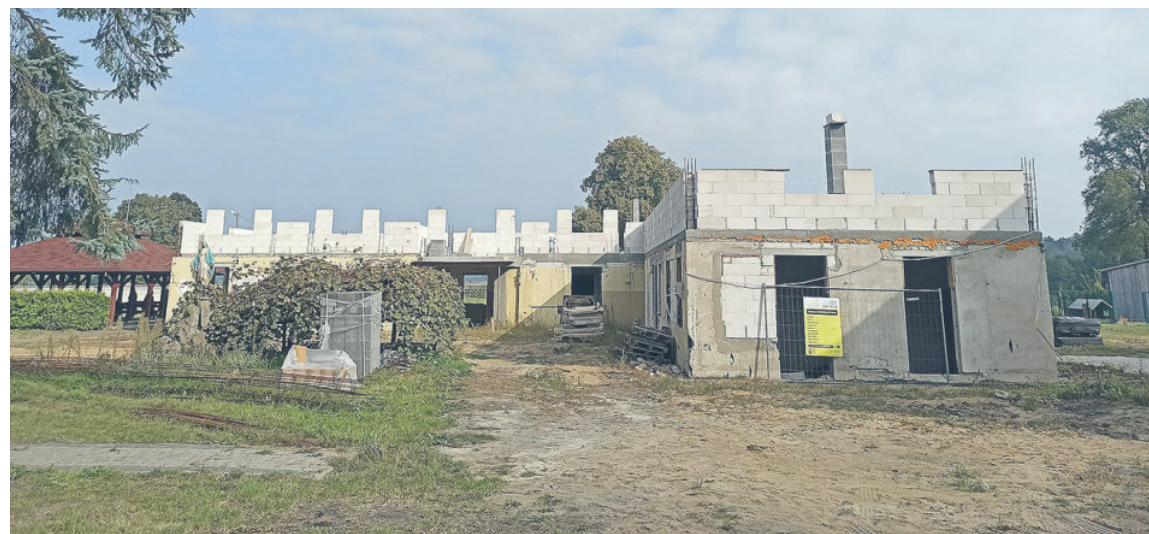
Budowa domu dialogu w Woli Gułowskiej
