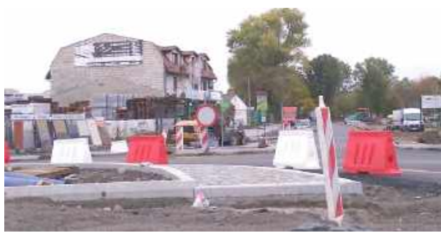
W przyszłym roku znów spore nakłady pójdą na przebudowę ulic przy tym skrzyżowaniu - Siderskiej i al. Jana Pawła II w ciągu do ul. Kościuszki (widać w głębi)
