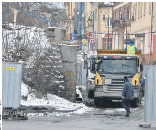
Trwa przebudowa wiaduktu nad Krakowską
