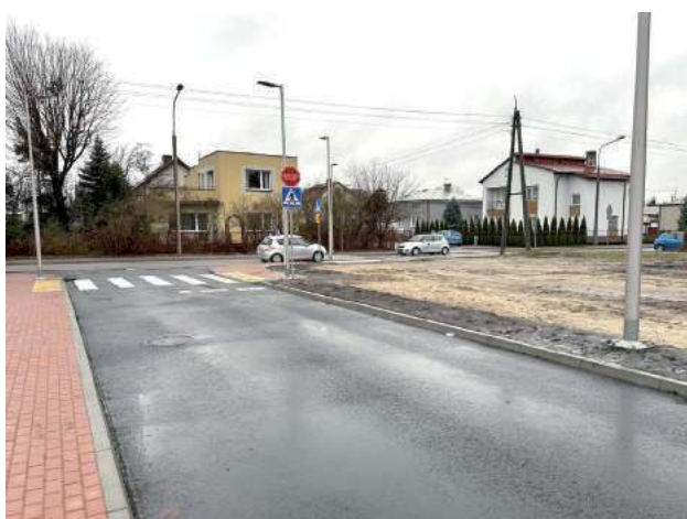
Ulica Rakowa jest już gotowa do użytku
