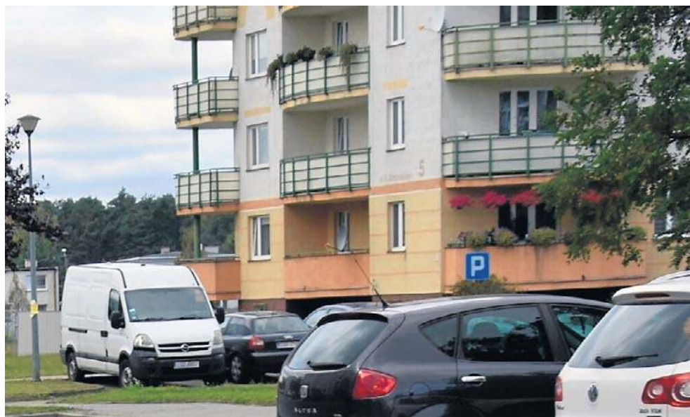
W bloku przy ulicy Żeromskiego 5 w Golubiu-Dobrzyniu planowany jest remont za 300 tys. złotych. Mieszkańcom podniesiono fundusz remontowy ze 1,3 zł za m2 na 2,3 zł
