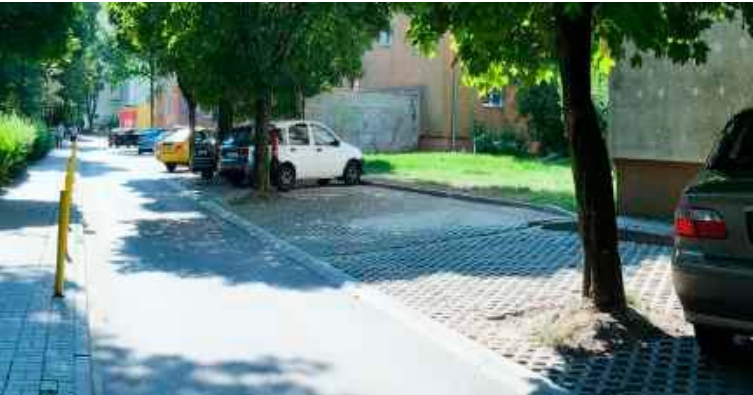
Wzdłuż wyremontowanej ulicy Sokolej powstały dodatkowe, ażurowe miejsca parkingowe
