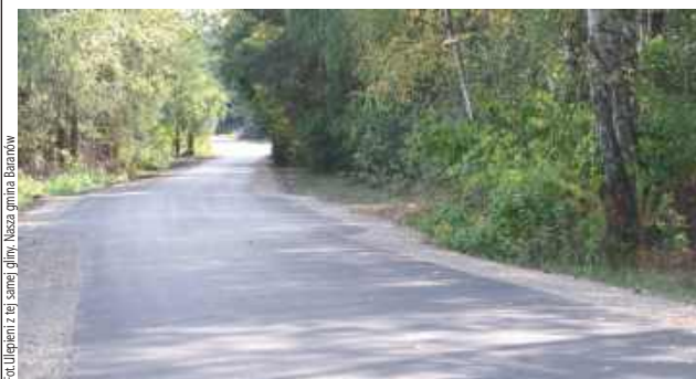
Zmodernizowana droga ma 452 metry długości
