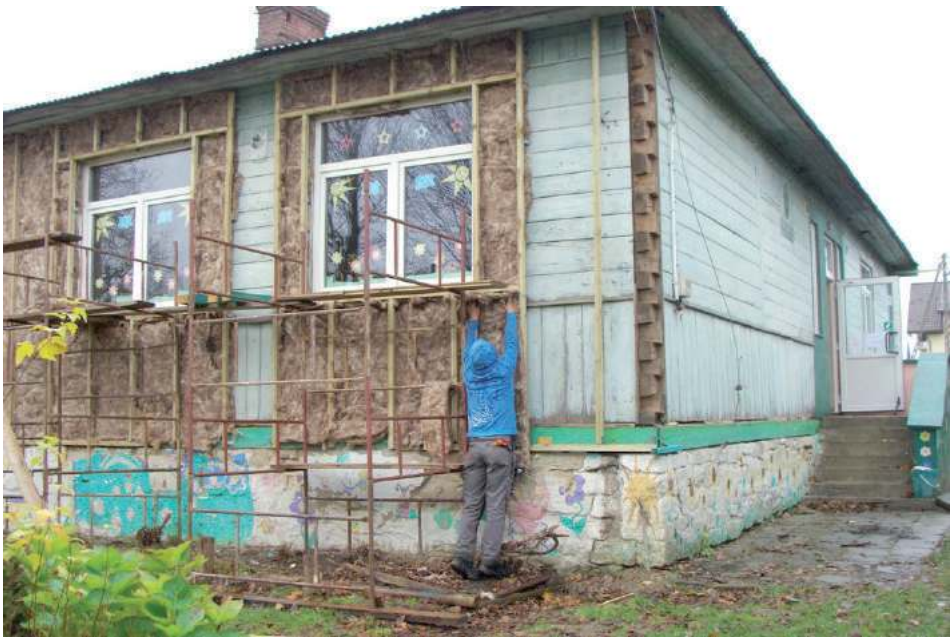
Świetlice w Długim Kącie i Borowinie już wkrótce mają być wyremontowane
