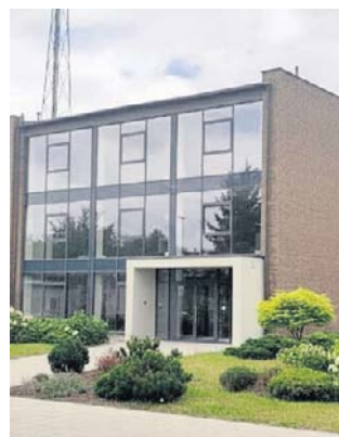
Stara kotłownia zmieni się w centrum kultury
