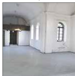
W drugim etapie prac wykonano posadzkę z kamienia naturalnego – granitu wraz z cokolikami, progami oraz obłożeniem schodów
