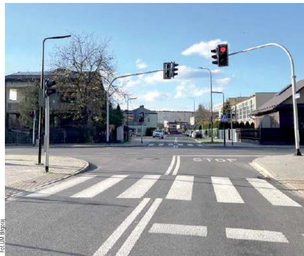
Ulica Piłsudskiego w Biłgoraju już po remoncie
