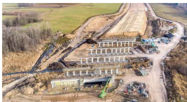
Pomimo przerwy zimowej, którą wykonawcy mają zapisaną w kontraktach, trwają zaawansowane prace nad autostradą A2 na wschód od Warszawy
