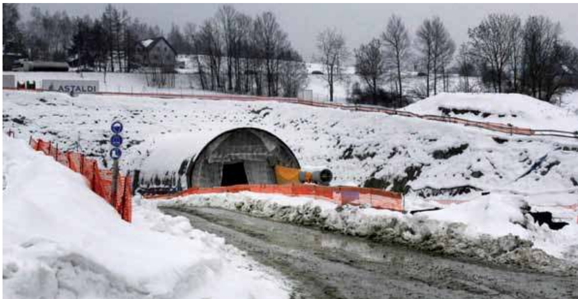
Plac przed północnym portalem jest pusty.
