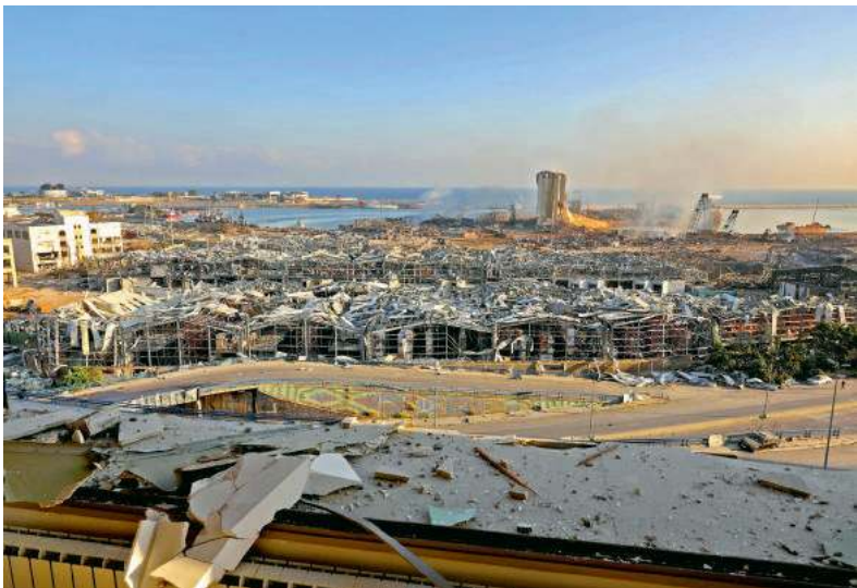
Skala zniszczeń po wybuchu jest ogromna.
