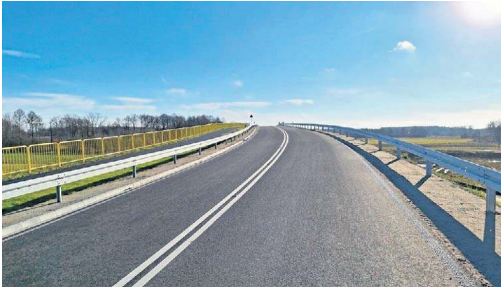
W Nowym Tomyślu dobiega końca jedna z najważniejszych inwestycji drogowych w regionie – budowa nowego przebiegu drogi wojewódzkiej nr 305 wraz z wiaduktem
