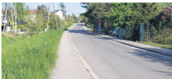
W trzecim kwartale br. zaplanowany jest remont chodników przy ul. Szkolnej w Przewornie
