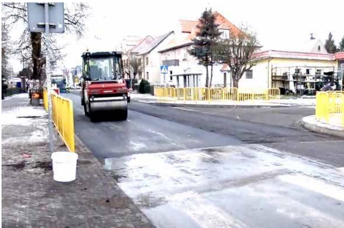
Ostatnie prace na ul. Wojska Polskiego prowadzone były w grudniu 2021 roku
