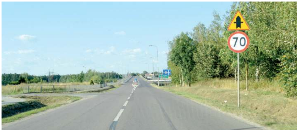
Jeżeli przyszłoroczny budżet powiatu puławskiego ułoży się pomyślnie dla Kurowa, na odcinku od ul. Wiśniowej do węzła ekspresówki powstanie chodnik. Prawdopodobnie zostanie wybudowany po prawej stronie drogi
