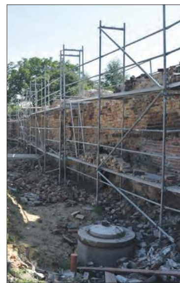
Fragment remontowanego odcinka murów w Białej
