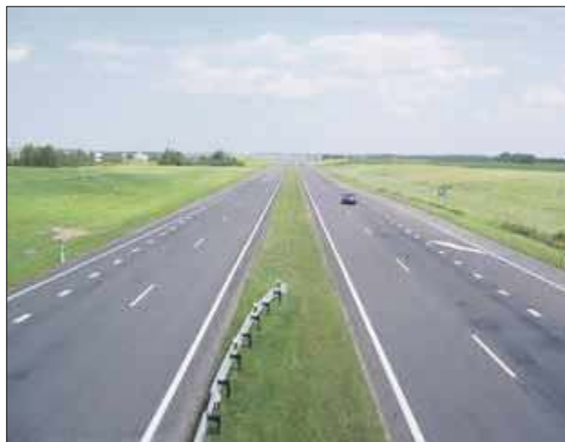
Budowa wschodniej obwodnicy Białej Podlaskiej jest ujęta w planie rozwoju sieci dróg wojewódzkich Województwa Lubelskiego na lata 2012–2020 w załączniku nr 2 pn. „Zadania inwestycyjne planowane do realizacji w perspektywie do roku 2030”
