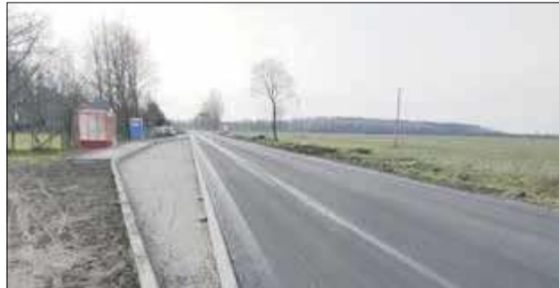
Drugi etap remontu trasy Janów-Podlaski-Ossówka jest już na zaawansowanym etapie m.in. wykonano już zjazdy na posesje i na pola oraz zatoki autobusowe
