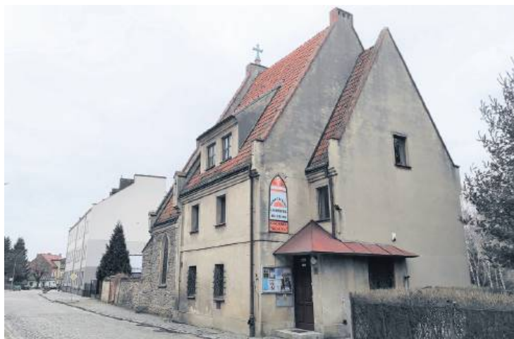
Gminie Strzelin przyznano 958.525,61 zł dofinansowania na remont i przebudowę zabytkowego budynku dawnej siedziby Strzeleńskiego Ośrodka Kultury przy ul. Brzegowej w Strzelinie
