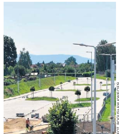
Budowa parkingu zbliża się do finału
