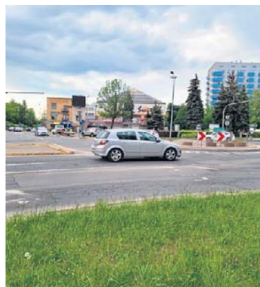
Przez ponad rok w tym miejscu rwać ma budowa ronda
