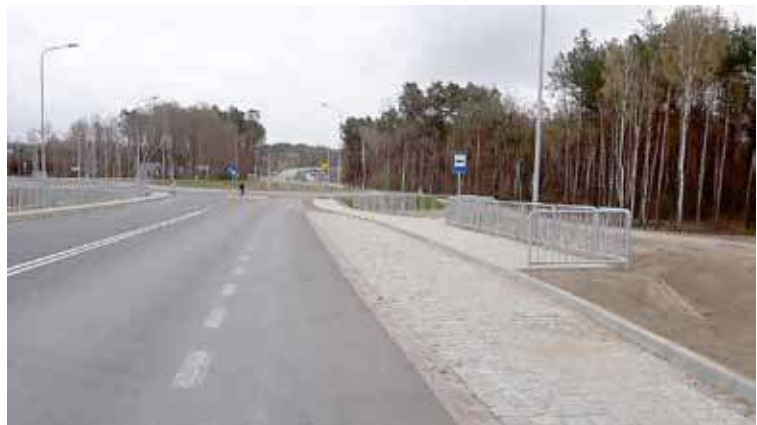
A to już nowa zatoka autobusowa na starej dk6, która zostanie oddana do użytku wkrótce. Stąd mieszkańcy Redostowa będą mogli dostać się np. do Nowogardu
