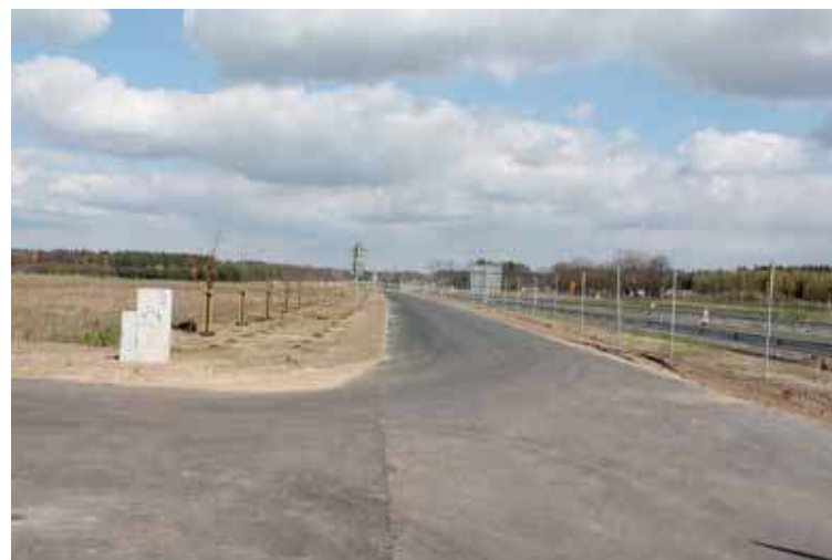
Zdjęcie wykonane na skrzyżowaniu z drogą do Redostowa, stanowiącą obecnie drogę pomocniczą dla nowej S6 - widoczną za siatką. To tu rozpoczyna się długa droga do najbliższego przystanku busa
