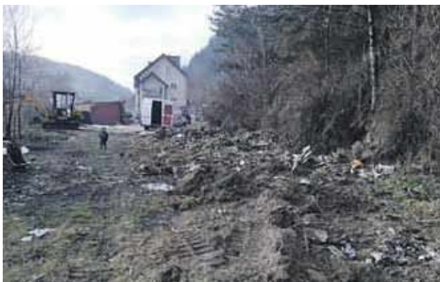
Odkopywaniem śmieci na osiedlu romskim w Ochotnicy zajmuje się firma zewnętrzna.
