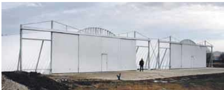
Osiemdziesiąt lat czekali nowotarscy lotnicy na nowe hangary. Poprzedni powstał w połowie lat trzydziestych ubiegłego wieku.
