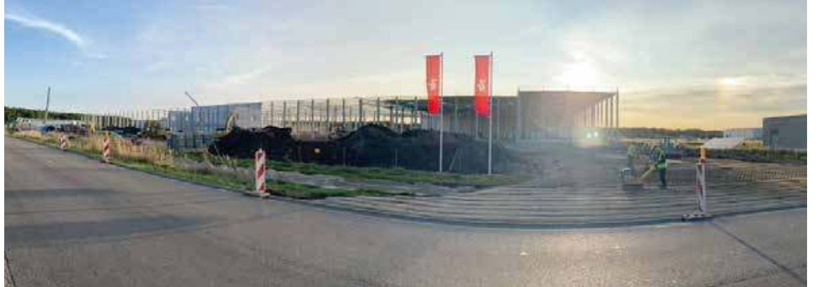
Budowa jest już bardzo zaawansowana, obiekt ma być gotowy za kilka miesięcy
